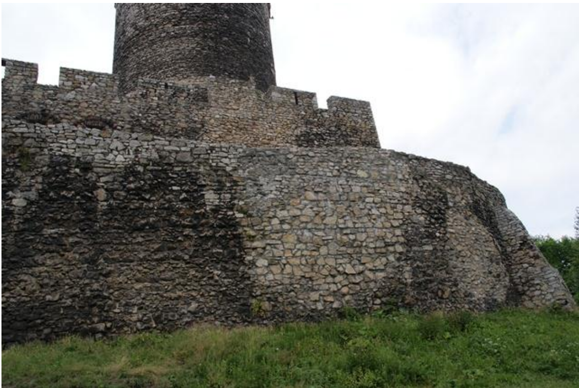
fot. nr 2 Elewacja wschodnia. W strukturze murów widoczne jaśniejsze partie przemurowań i napraw.
