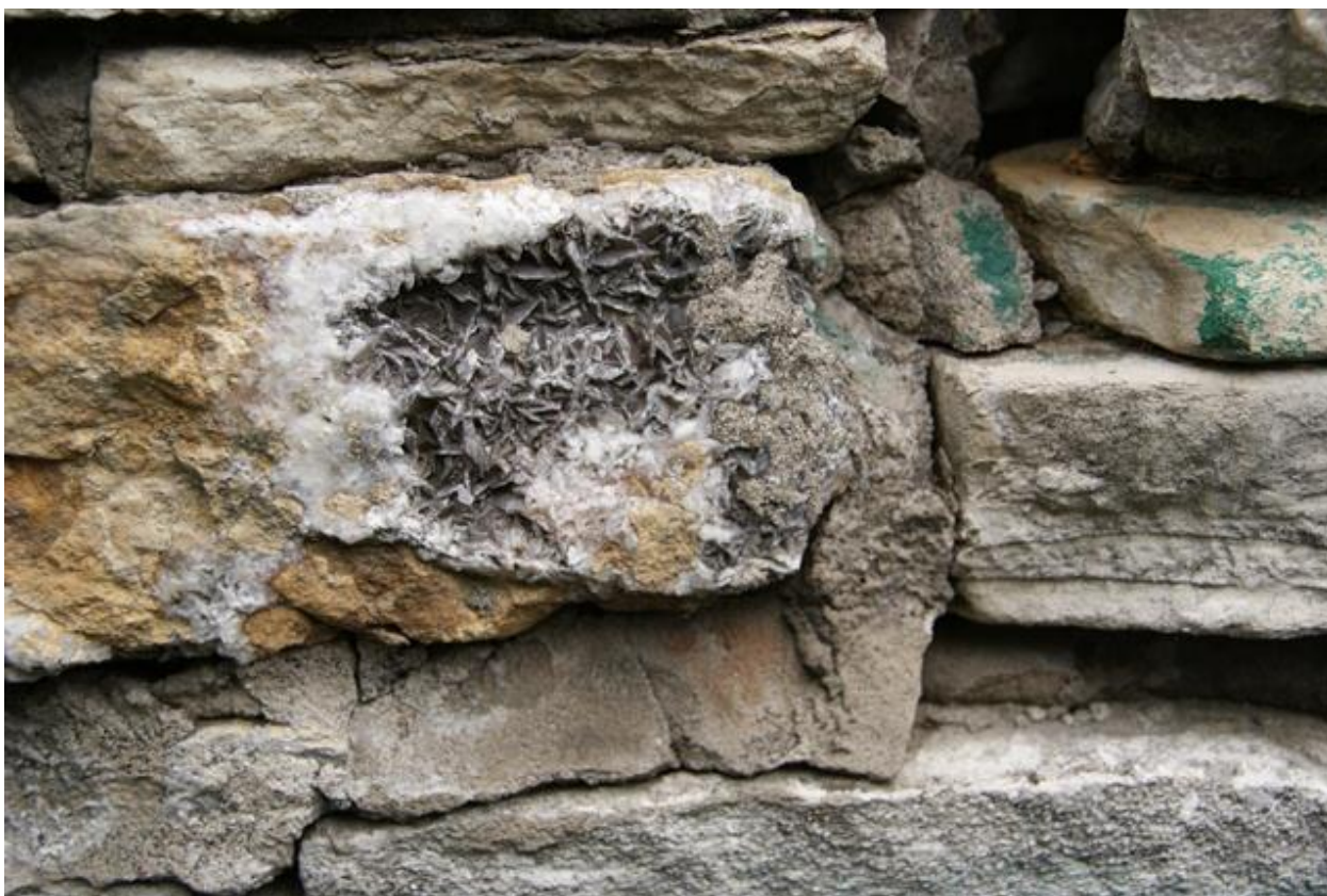
fot. nr 10 Kryształy soli na powierzchni kamienia ruin obwarowań zewnętrznych.
