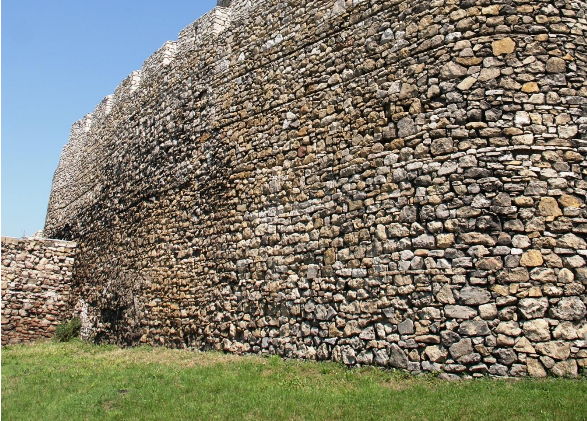
fot nr 1 Elewacja południowa. Struktura murów wykonana z układanego poziomymi pasami kamienia łamanego, głównie wapienia.
