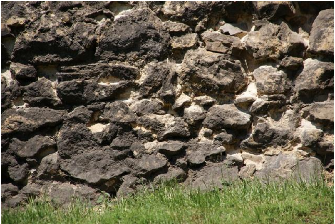
fot. nr 3 Elewacja wschodnia murów. Styk z gruntem. Wysypywanie się wapiennych spoin, zapraw powoduje rozluźnienie wążku kamiennego.
