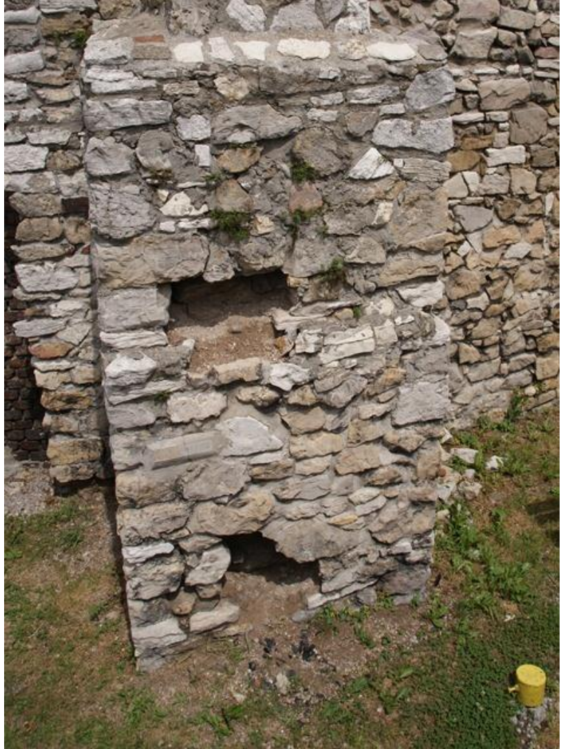
fot. nr 8 Spękane spoiny cementowe umożliwiają wnikanie wody co prowadzi do powstania zniszczeń muru.
