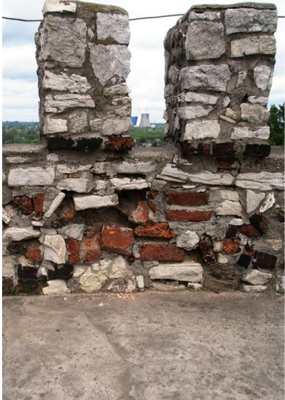
fot. nr 5 Uszkodzenia na krenelażu wieży. Odspojone płyty zaprawy cementowej, ubytki cegieł, kamieni, spoin.
