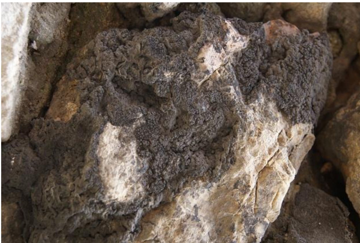
fot. nr 9 Ciemne, grube nawarstwienia tzw. kor gipsowych, kontrastujące kolorystycznie z jasnym kolorem wapienia.
