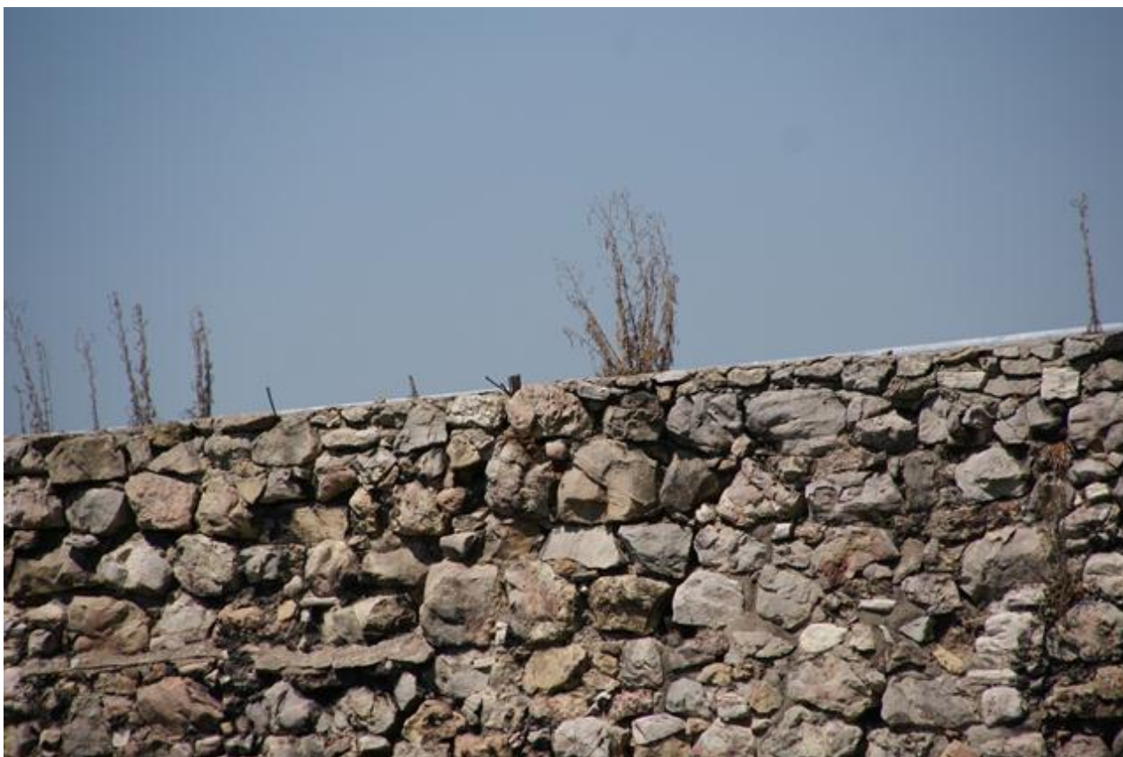
fot. nr 6 Nieszczelna i wilgotna siatka spoin ułatwia rozwój niepożądaney mikroflory i makro flory; drzew, mchów, trawy, drobnych roślin.
