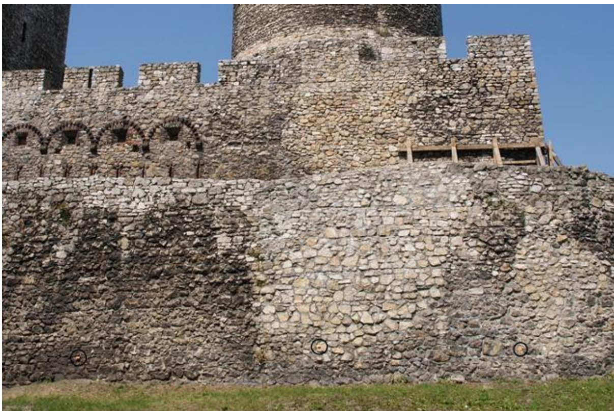
Fot. nr 11 Elewacja wschodnia. Miejsca pobrania próbek do badania poziomu zasolenia, zawilgocenia i składu zapraw, dolnej osłabionej partii murów.
